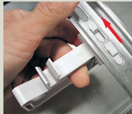
A vízszintes elhelyezést biztosító kábelvezető gyűrűk rögzítése
