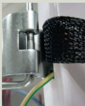
Ha levesszük a műanyag takarólapot, 4 vezetéket is bevezethetünk az elosztószekrénybe
