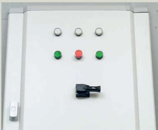
Jelző és működtető készülékek és mellső meghosszabbított rotációs hajtás az ajtón
