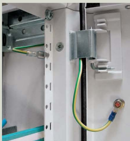
Ha levesszük a műanyag takarólapot, 4 vezetéket is bevezethetünk az elosztószekrénybe
