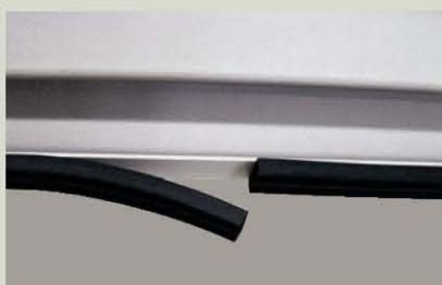
A tömítés illesztése az ajtó alsó részén legyen
